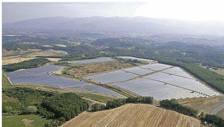
Figura 4. Impianto FV di Santa Barbara a Cavriglia
