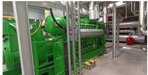
Figura 6. Intervento di nuova realizzazione impianto di cogenerazione Ospedale Nottola, Azienda USL Toscana Sud Est
